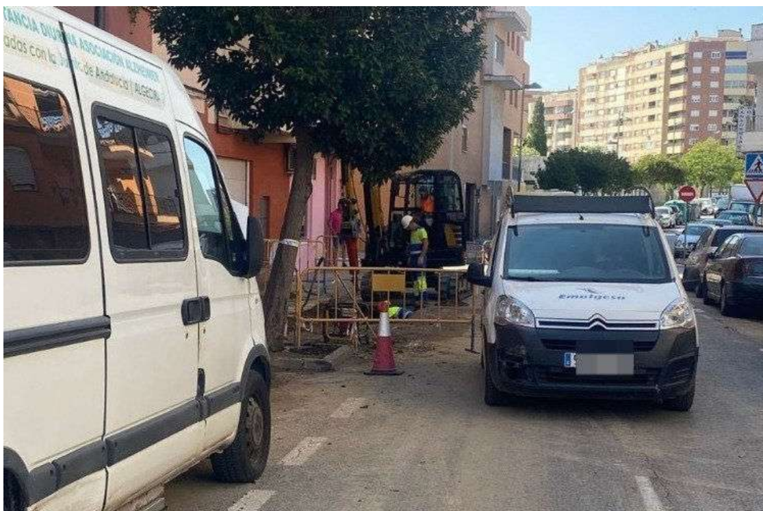
Los efectivos de Emalgesa trabajan en la reparación de una avería. / Archivo Área
